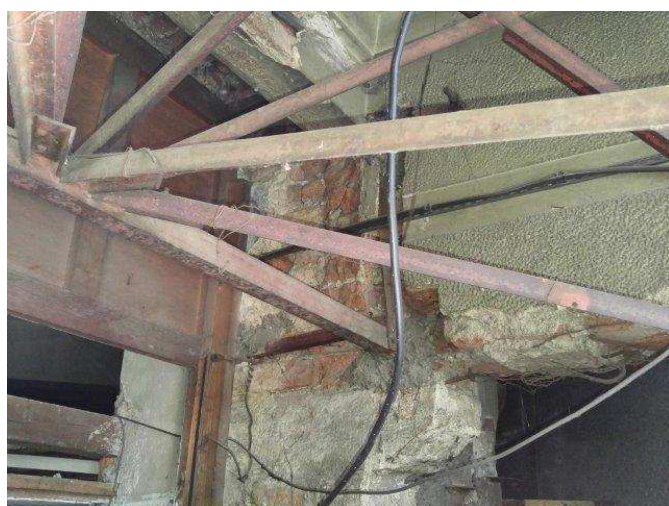
foto /25/ Pohled na uchycení lehké konstrukce, která zakrývá nosné prvky
