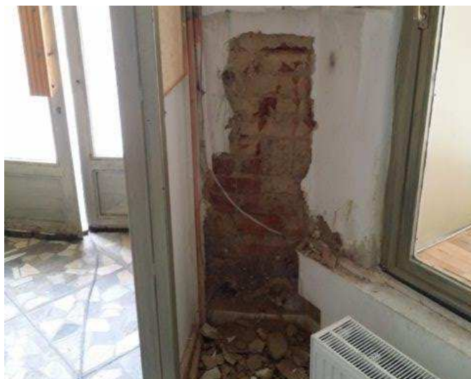
foto /12/ Pohled na sondu do zdi S7
