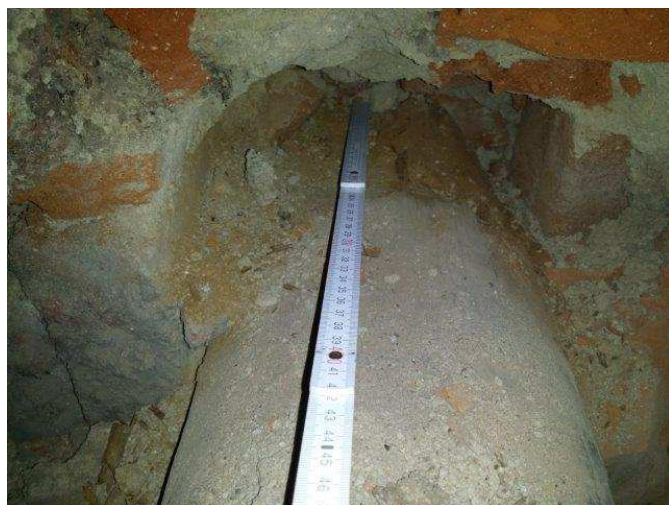
foto /19/ Detail uložení trámu ve stěně sondy S10
