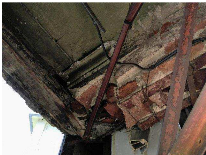
foto /22/ Pohled na nosnou konstrukci arkýře – konzola s částečně opadanou obezdívkou
