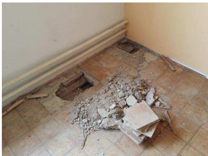
foto /1/ Pohled na provedení sondy do podlahy
