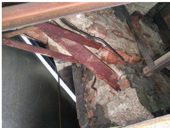
foto /23/ Pohled na nosnou konstrukci arkýře – vzpěra s opadanou obezdívkou
