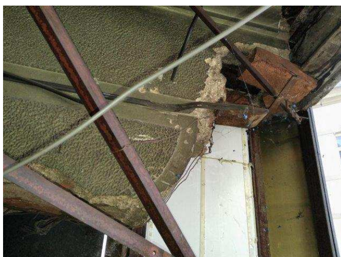
foto /24/ Pohled na nosnou konstrukci arkýře – konzola a vzpěra v částečně opadané obezdívce
